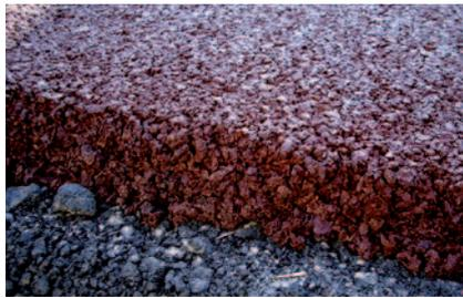
*Bild 1: Rot eingefärbter Asphalt mit schwarzem Bindemittel*
